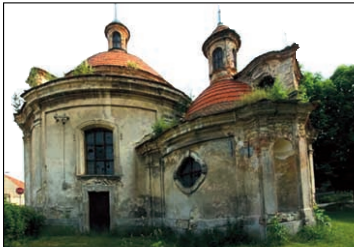
Původní zanedbaný stav kapličky.
